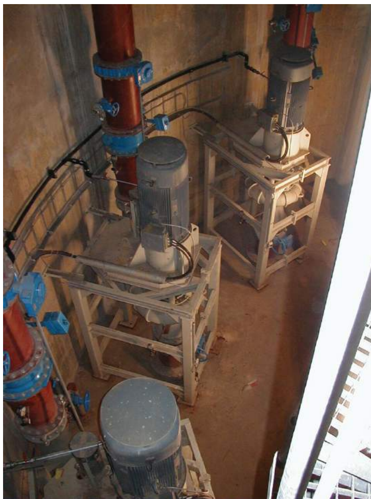
NPW 300/530 V1 установлен на металлургическом комбинате для перекачивания воды с агломератом
